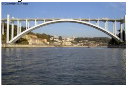
Imagem 1 – Ponte de arco
